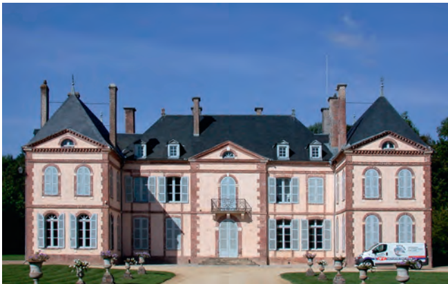
Schloss Auxerre, Frankreich: Installation BestBoard Heizleisten Elektrosystem, 2002
