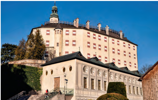
Schloss Ambras, Österreich: Installation BestBoard Heizleisten Wassersystem, 2012
