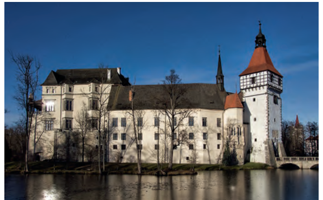
Schloss Blatná: Installation BestBoard Heizleisten Elektrosystem, 2016
